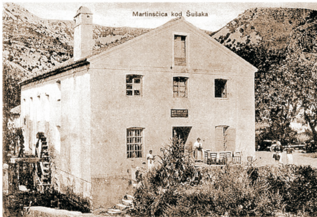
Martinšćica, 1910. godine. Razglednica Čabrijanovog mlin vodeničara (izdavač Radici - Tome, Fiume). Na lijevoj strani zgrade vide se dva (od četiri) velika kotača s lopaticama koji su vodom iz potoka pokretali mlin. U to vrijeme vlasnik je bio Mate Čabrijan iz Grobnika.
