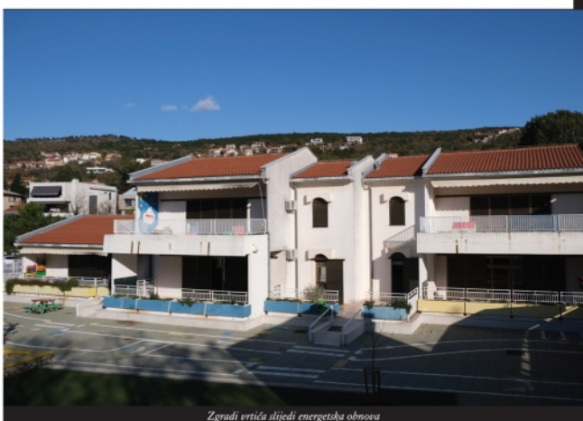
Zgradi vrtića slijedi energetska obnova
