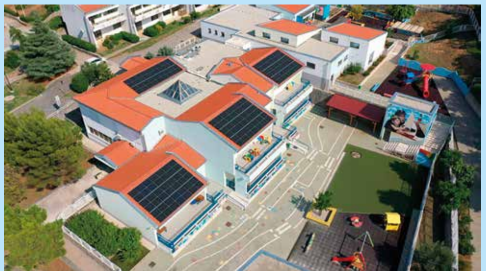
Nakon energetske obnove kostrenski vrtić dobio je i fotonaponsku elektranu za proizvodnju energije iz obnovljivih izvora čime će se dodatno smanjiti energetske troškovi kao i ugljični otisak vrtića. Projekt je ostvaren uz sufinanciranje Fonda za zaštitu okoliša i energetske učinkovitost.
