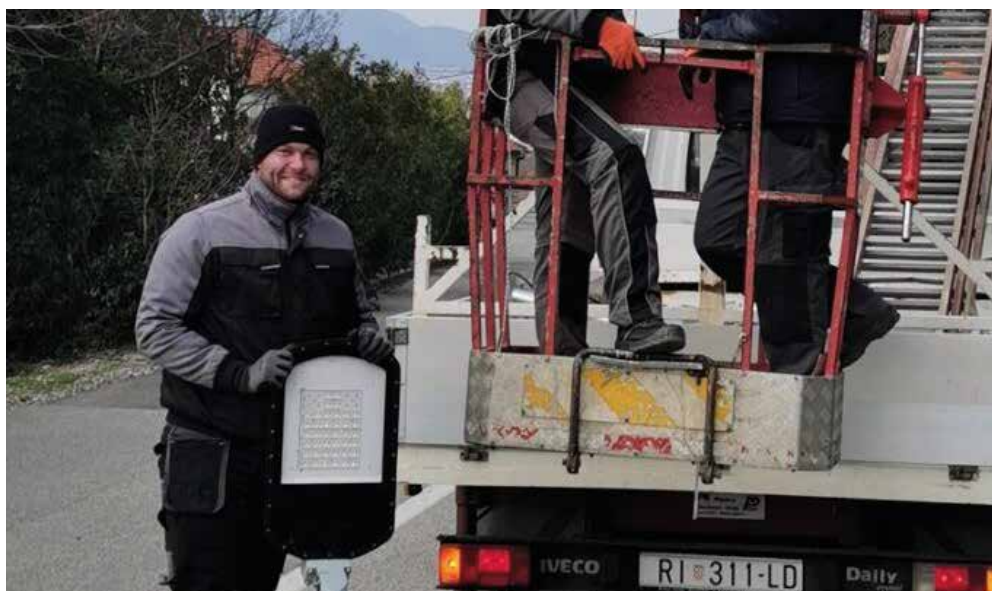
Na dionici od Plešića do Randića zamijenjena su 63 rasvjetna tijela novim i učinkovitijim LED žaruljama s ciljem unaprjeđenja javne rasvjete
